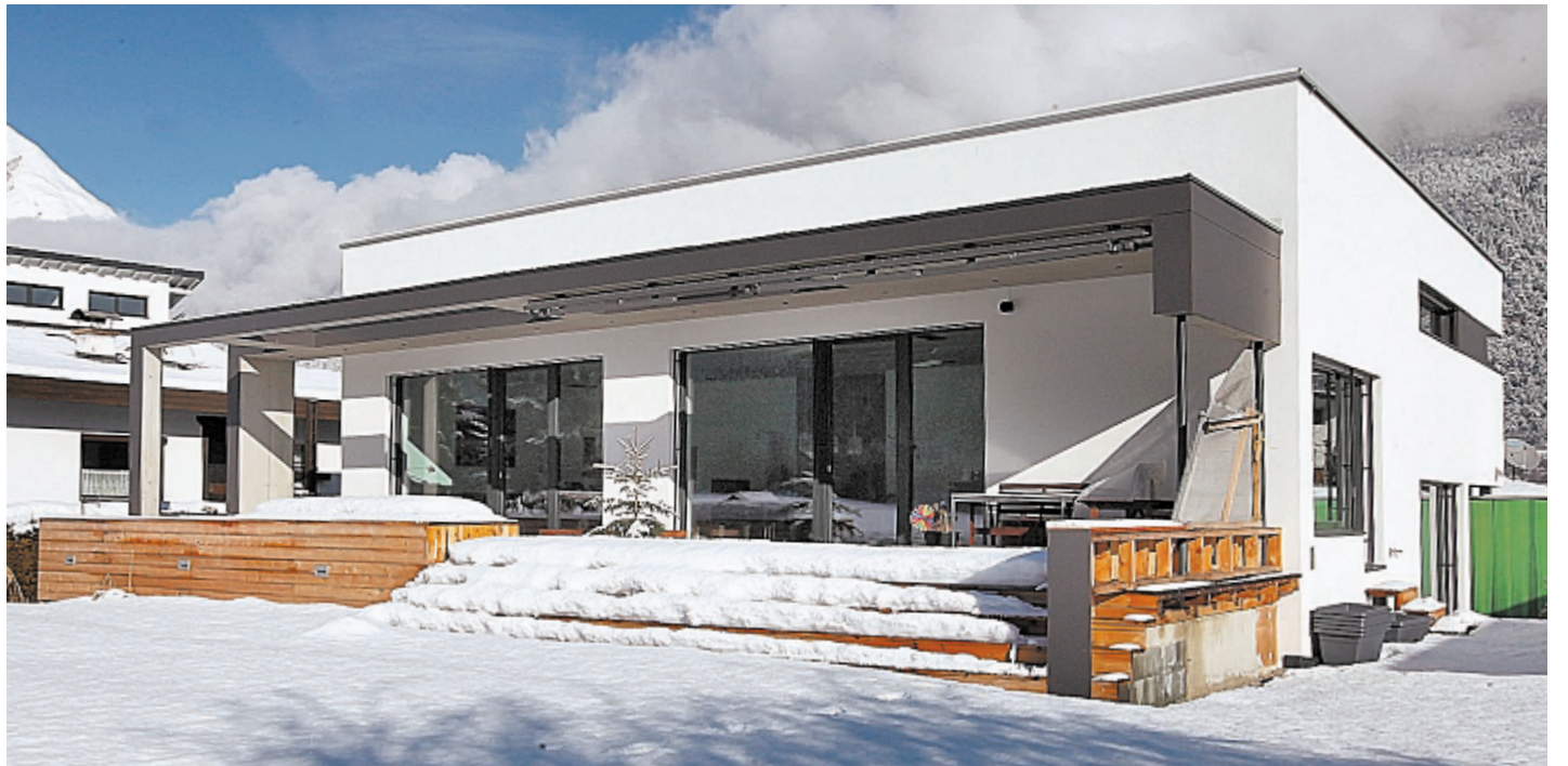
Das Haus in Flauring hat einen äußerst niedrigen Energieverbrauch. Die Sonnenkollektoren auf der Dachterrasse sind nicht sichtbar.
